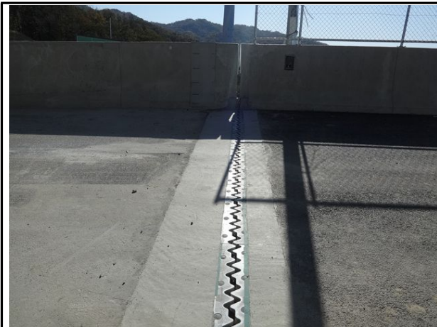
신축이음 A2 전경
