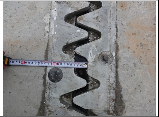
신축이음 A1 유간 측정
