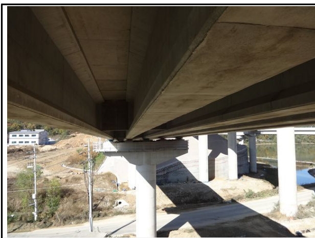
PSC BEAM 전경
