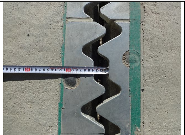
신축이음 A2 유간 측정
