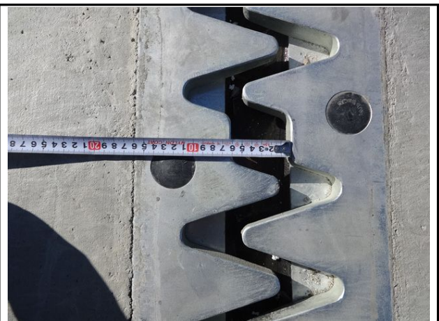
신축이음 P2 유간 측정
