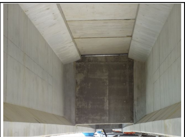
거더 및 가로보 전경
