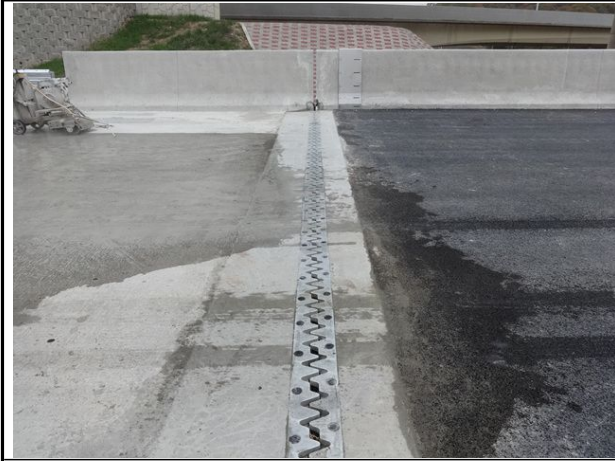
신축이음 A1 전경
